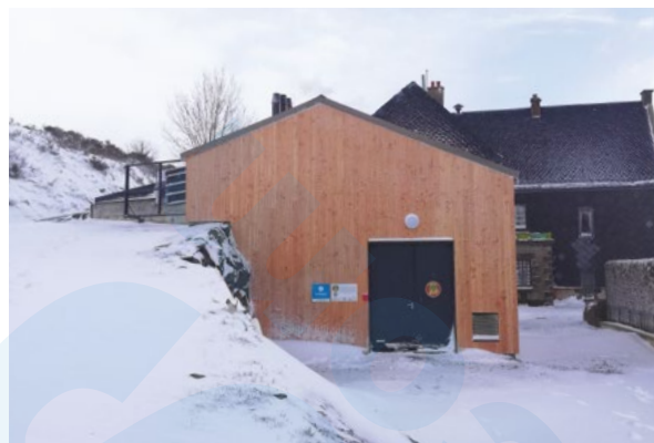
Chaudière bois du réseau de chaleur d'Anzat-le-Luguet (Puy-de-Dôme).
