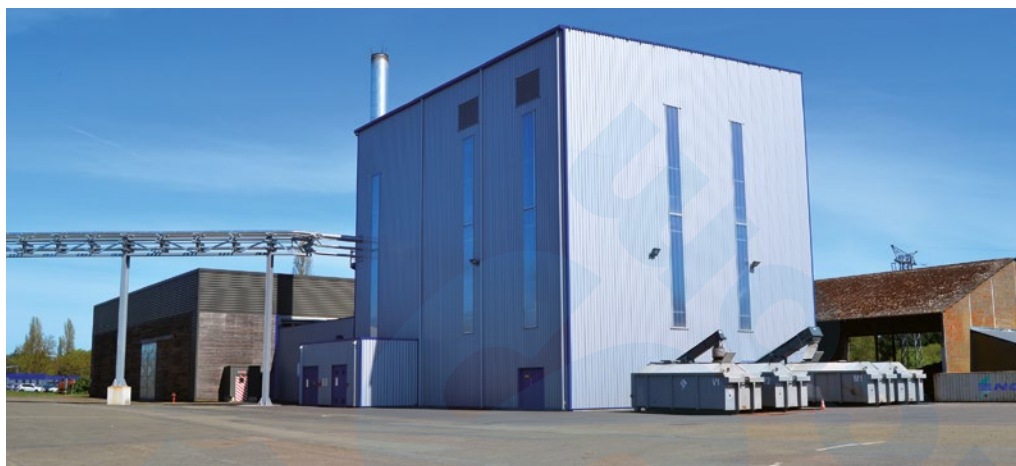
Installation biomasse du site de Spay (72).
